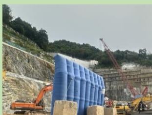
設置可重覆使用的隔音屏障 Installation of Reusable Noise Barriers
